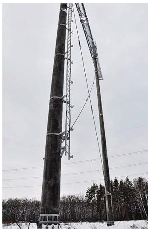
Рис. 8 – Лестница опоры с анкерными петлями
