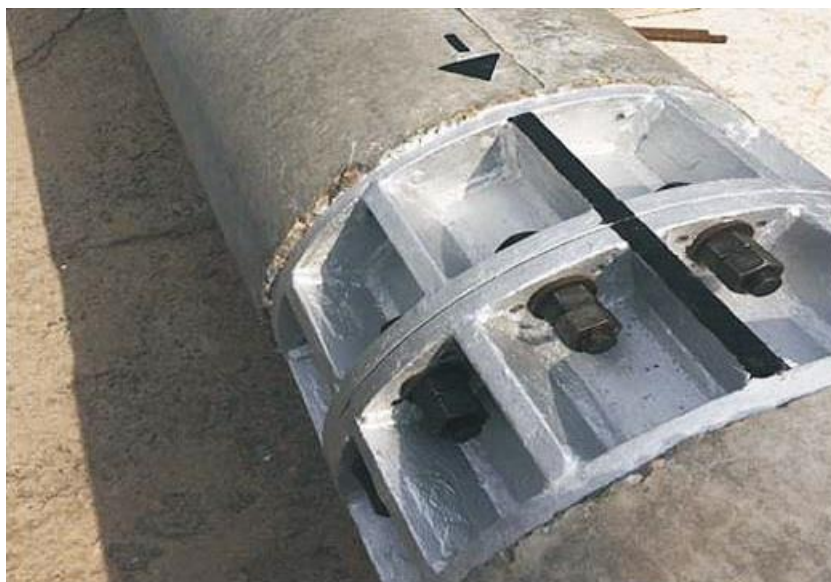
Рис. 2 – Внутренний фланец для соединения секций (типовое решение)
