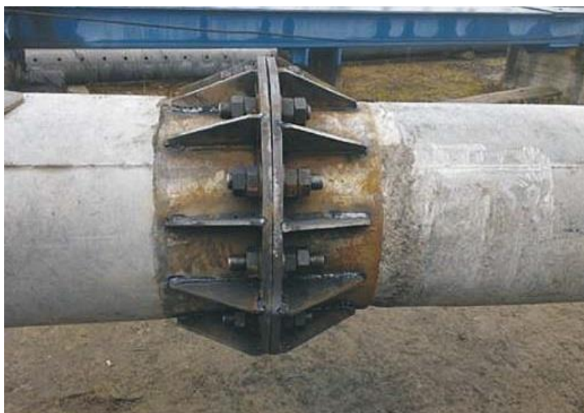
Рис. 1 – Внешний фланец для соединения секций стойки (первоначальный вариант)
