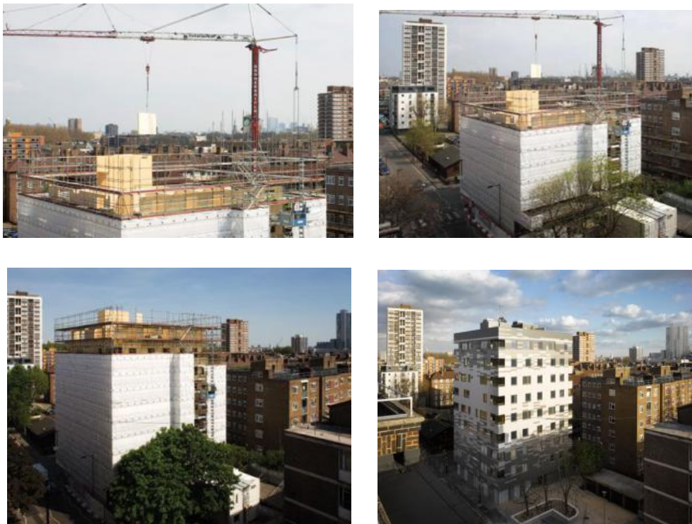
Рис. 3 – Технология возведения 9-ти этажного деревянного жилого дома в Лондоне
