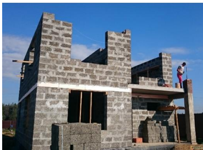
3-сурет – Қызылорда облысы Шиелі кентінде қож-сілтілі байланыстырғыш және күріш қауызы негізіндегі арболит блоктардан салынған шағын қабатты тұрғын үйдің құрылысы
