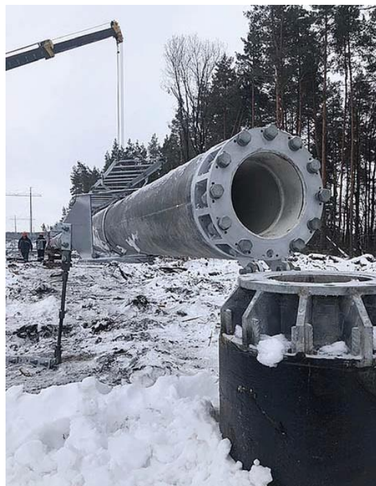
Рис. 12 – Фундамент опоры 2СПБ500-3В
